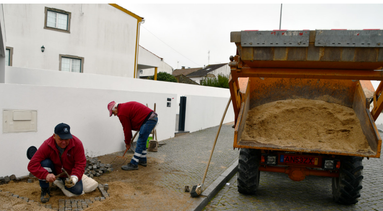
NISA Reparação de calçada
