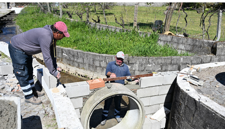
FALAGUEIRA Instalação de conduta
