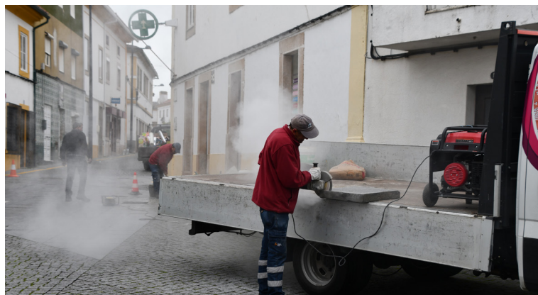
NISA Reparação de lajetas
