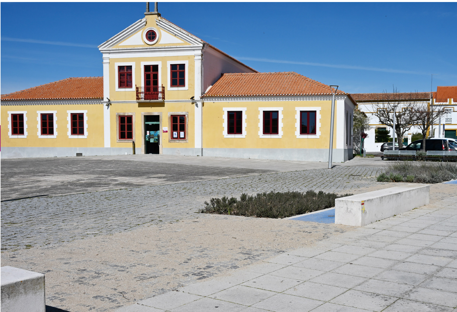
NISA Substituição de pavimento na Praça da República
