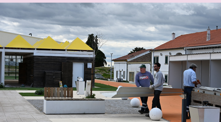
ALPALHÃO Montagem da Feira dos Enchidos
