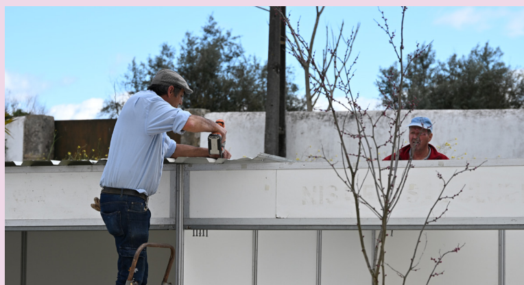
ALPALHÃO Montagem da Feira dos Enchidos
