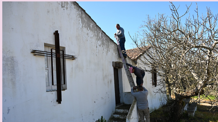
NISA – Trabalhos de beneficiação na Sra. da Graça
