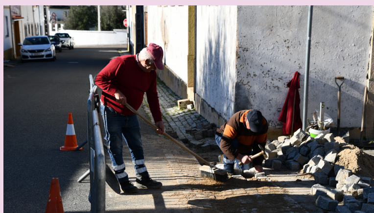
NISA Reparação de calçada
