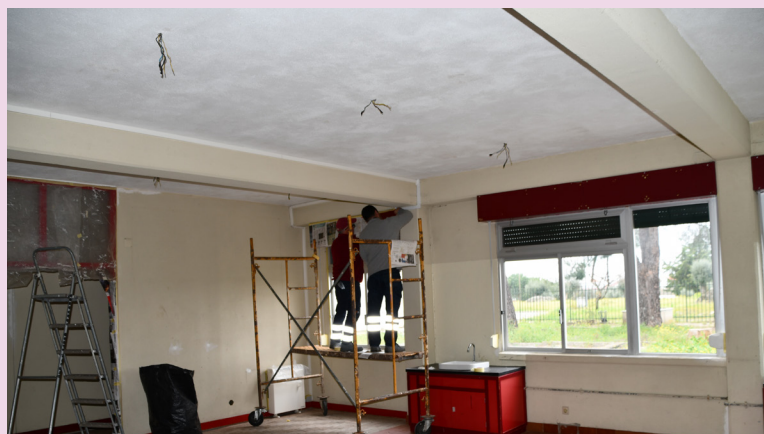
NISA - Melhoramentos no antigo bloco B da escola
