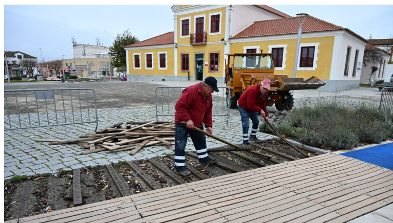
NISA – Substituição de pavimento na Praça da República
