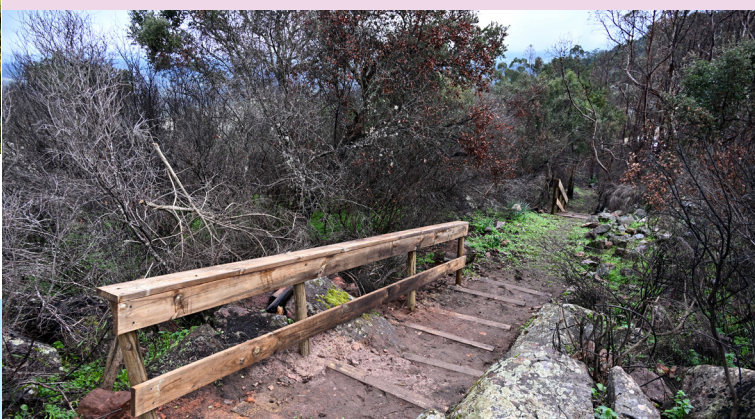
Reparação do PR5NIS
