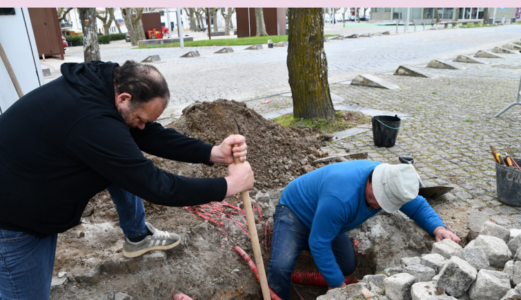
NISA - Reparação de rotura de água na Praça da República
