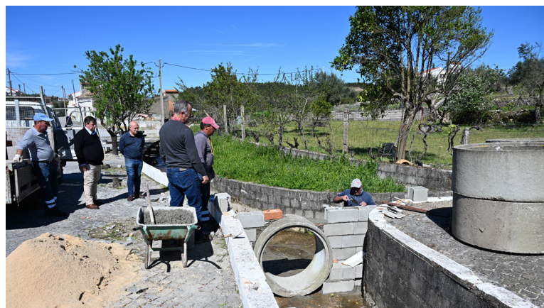
FALAGUEIRA Instalação de conduta
