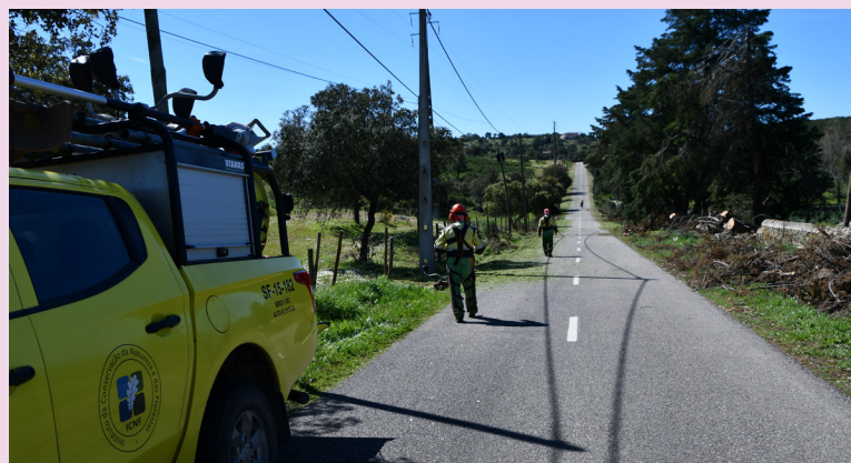
NISA – Limpeza do acesso à Capela da Sra. da Graça
