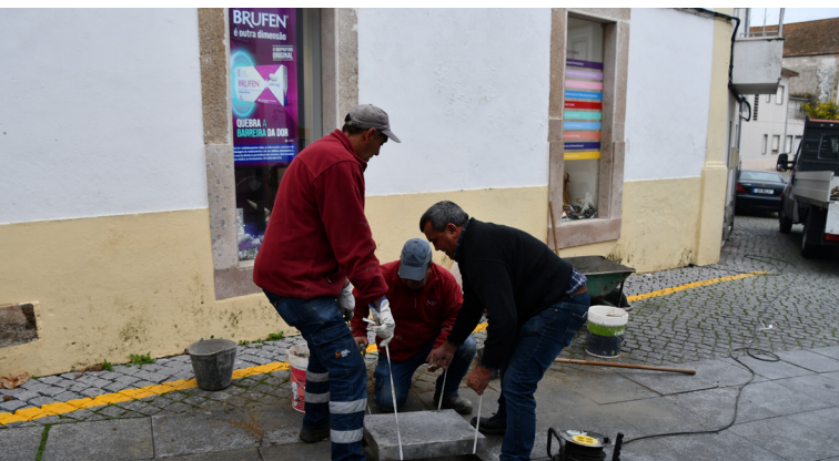
NISA Reparação de lajetas
