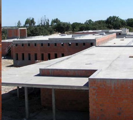
Aspecto do avançado estado das obras no novo Complexo Termal
